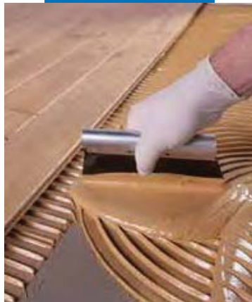
Aplicarea Ultrabond P990 1K
